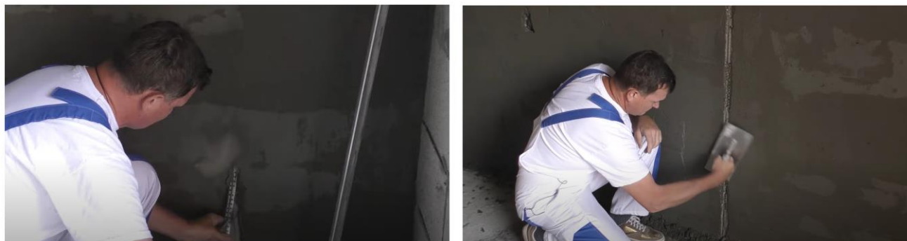
Рис. 25. Схема демонтажа маяков и заделки образовавшихся борозд
